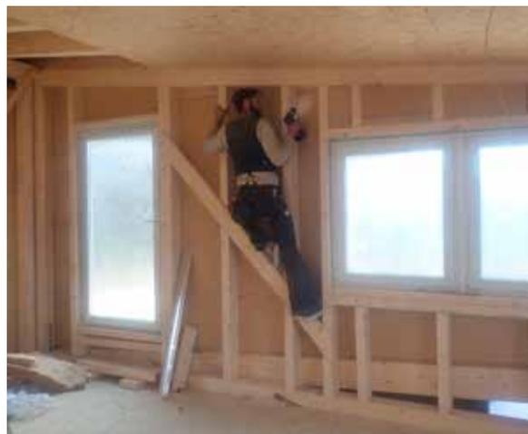
Torben Lüth bei einem Neubauprojekt im Bergischen Land: Die Holzrahmenwände wurden außen und innen mit Holzfasersplatten beplankt und mit Holzfasereinblasdämmung ausgeflockt
